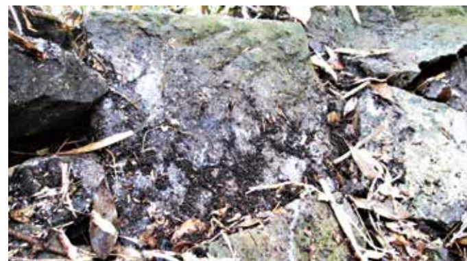
鑿切り仕上げをした石が積まれた野馬土手
