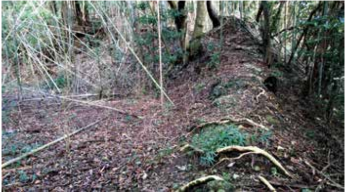
仲町の仮囲い 山をカットし崖と平坦地を造り出し平坦地の端を土手で塞ぐ
