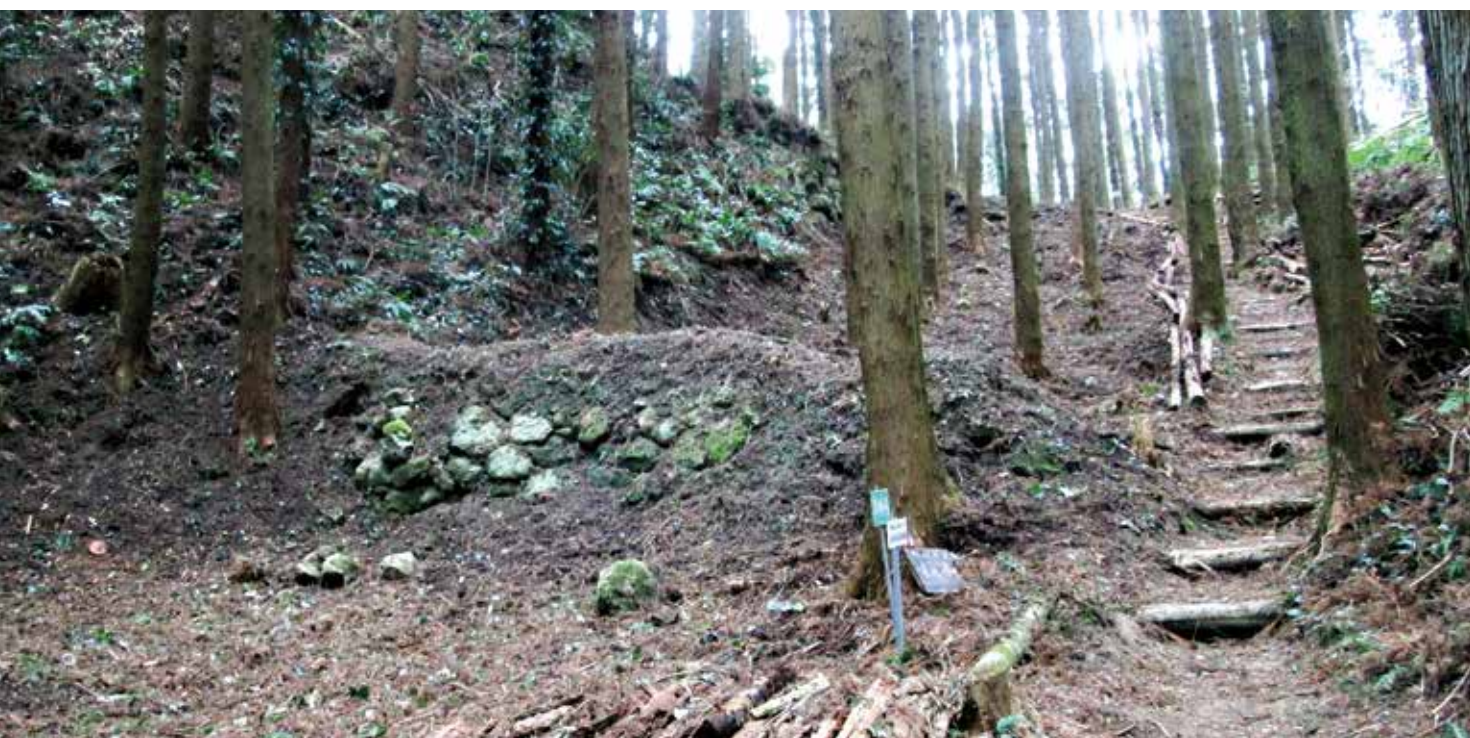
柱木牧の馬捕り場 斜面に造られている馬捕り場の柵 石垣の上に土盛りをして築いた仕切り土手
