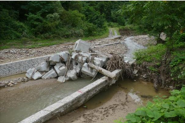
萩生川上流の河川砂止めテトラの崩壊と流木
