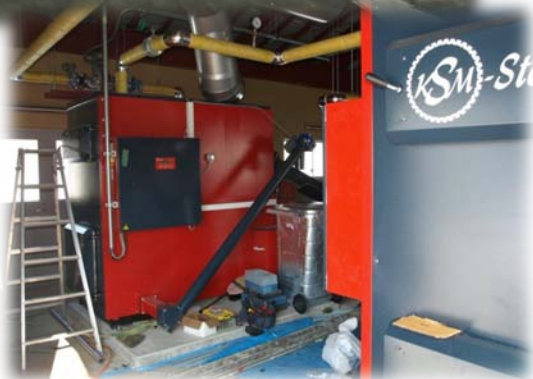
福島県内で最初に導入した デンマーク製の 木質チップボイラー
